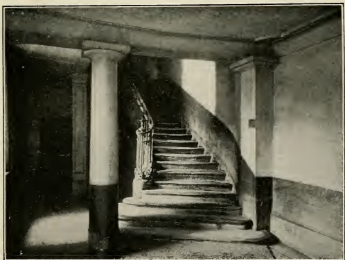
ANCIEN HOTEL D'ORVILLERS
