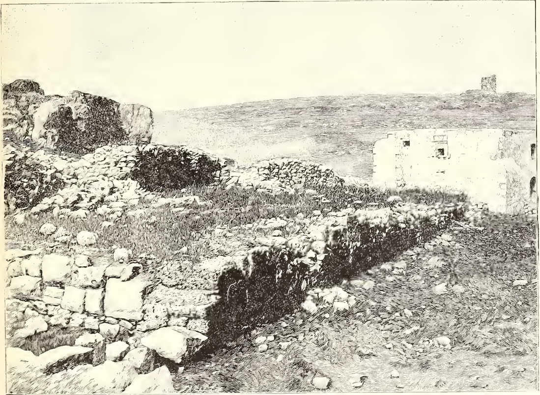
531. — Ruines de Bethsur. D'après une photographie de M. L. Heidet.
