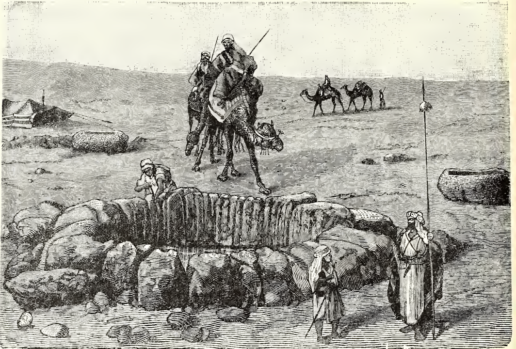
494. — Puits de Bersabée. D'après une photographie.
