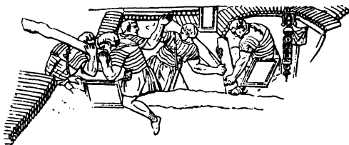
Construction d'un retranchement. (Bas-relief romain.)
